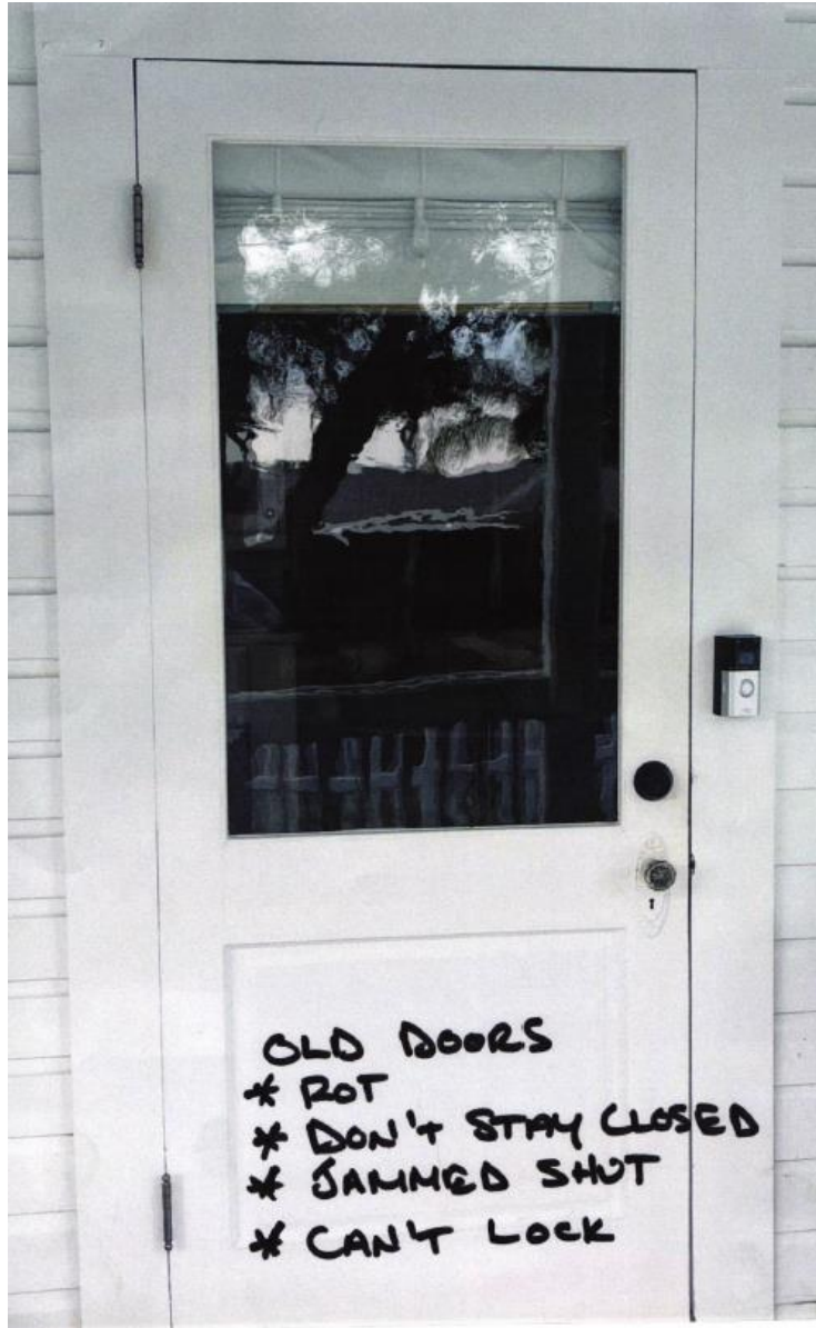
Existing Wood Door
